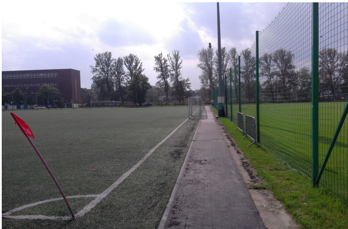
Zniszczona nawierzchnia boiska, opaska betonowa przewidziana do rozebrania
